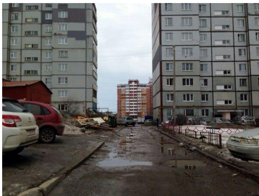
Подъезд со стороны ул. Окружное шоссе, д. 23
